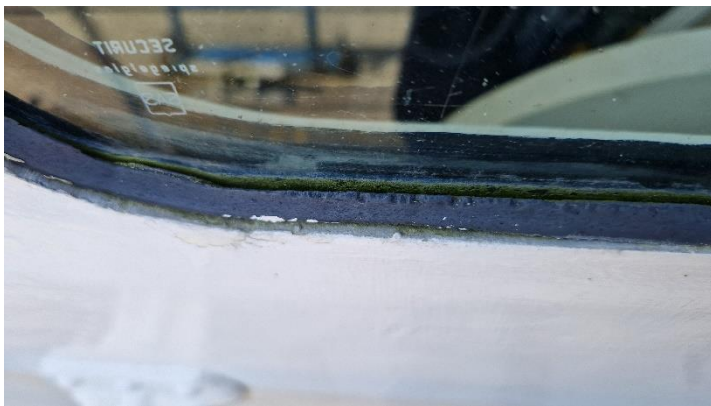
Verweerde raamrubbers (boven en rechts)
